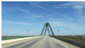
Fehmarnsund Brug fra syd, fotograferet på den europæiske motorvej E47
