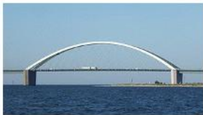
Fehmarnsundbroen (1963) vanuit het oosten (beschermd monument)
